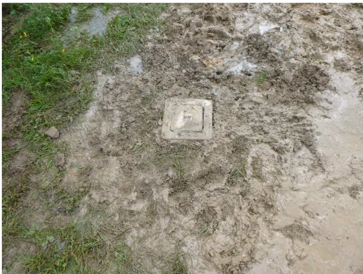
S 1: pozzetto protettivo i cls carrabile
